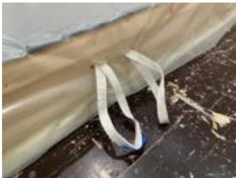
Bild: Lyftpunkter i takelement och nödvändig godkänd fyrpartskätting till kran.
